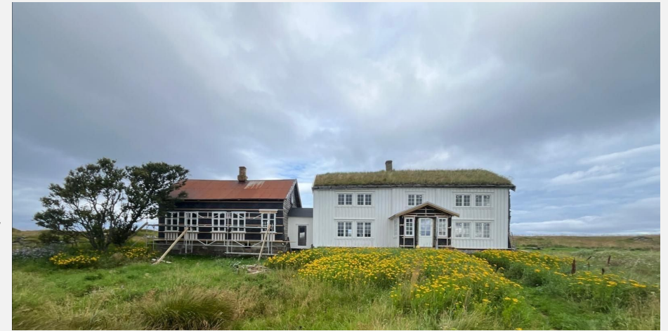
Her står hovedhuset. Som også kan ses i senter av skisse overfor. Rehabiliteringen er godt i gang og mindre investeringer utendørs og innendørs gjenstår før det er ferdig.
